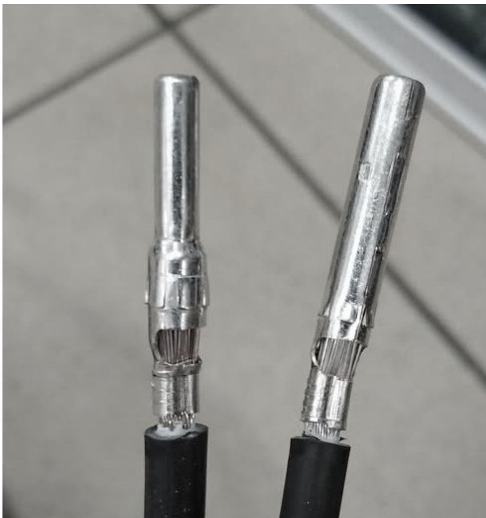
Rys. 29. Kontrola jakości zaciśniętych konektorów
